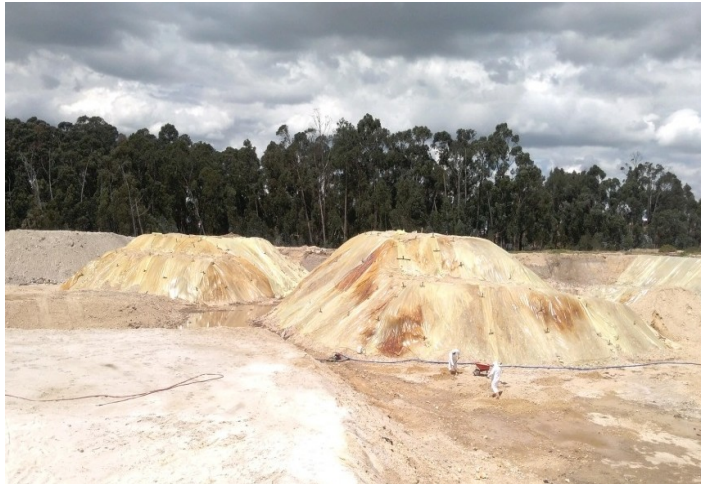
Fotografía 24. Material acopiado al interior de zona de excavación
