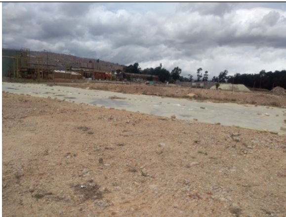
Fotografía 17. Zona acondicionada para pruebas de remediación
