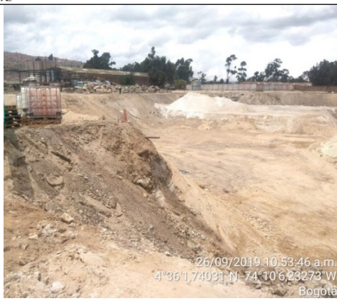
Fotografía 4. Zona de excavación
