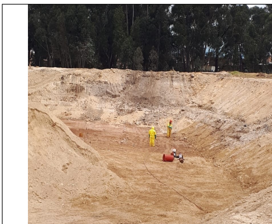
Fotografía 5. Aplicación de persulfato
