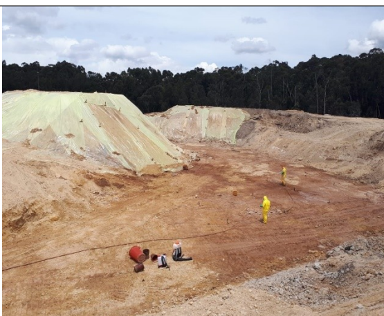
Fotografía 6. Aplicación de persulfato
