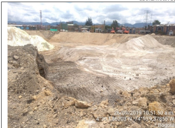
Fotografía 3. Zona de excavación
