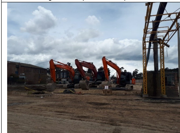
Fotografía 7. Retroexcavadoras en el lugar
