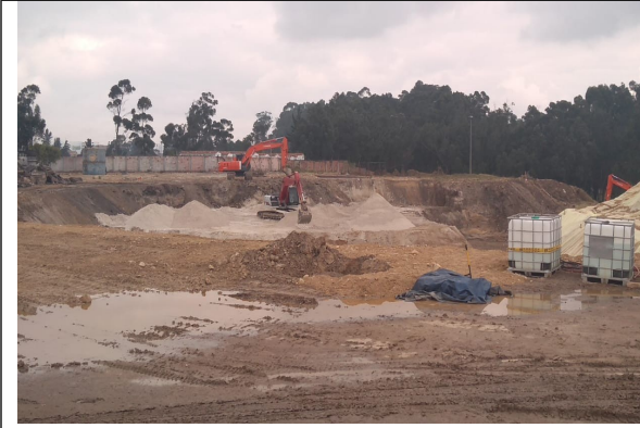
Fotografía 15. Panorámica de excavación
